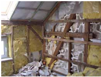
Das alte, unbrauchbare Dämm-Material musste entfernt werden, weil es die Raumfeuchte speicherte und damit der Schimmelpilzbildung Tür und Tor öffnete.
